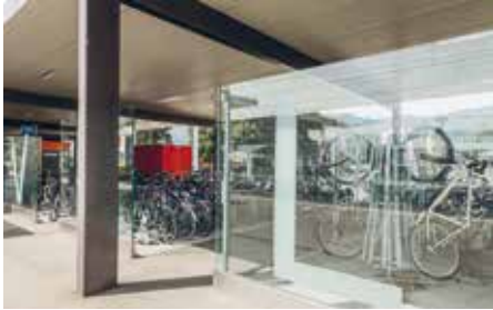
Kombination von abschliessbarer und offen zugänglicher Veloparkieranlage am Bahnhof Altstätten
