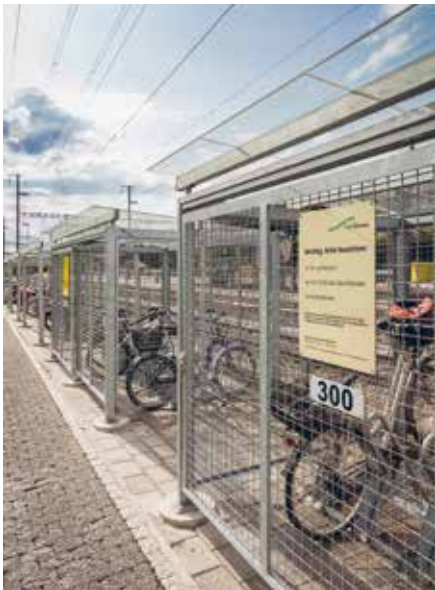
Abschliessbare, gedeckte Veloparkierung am Bahnhof Gossau
