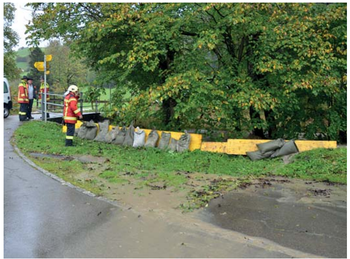
Bild 14. Intervention der Feuerwehr beim Durchlass Schwendi-strasse (Wildhuser Thur) in Unterwasser.
