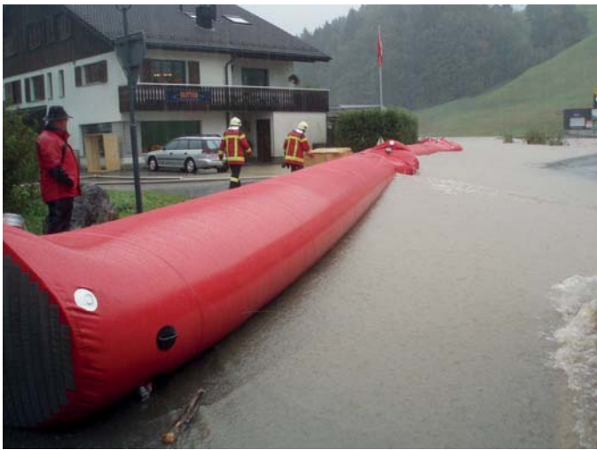
Bild 13. Hochwasserschutzschläuche in Alt St. Johann.
